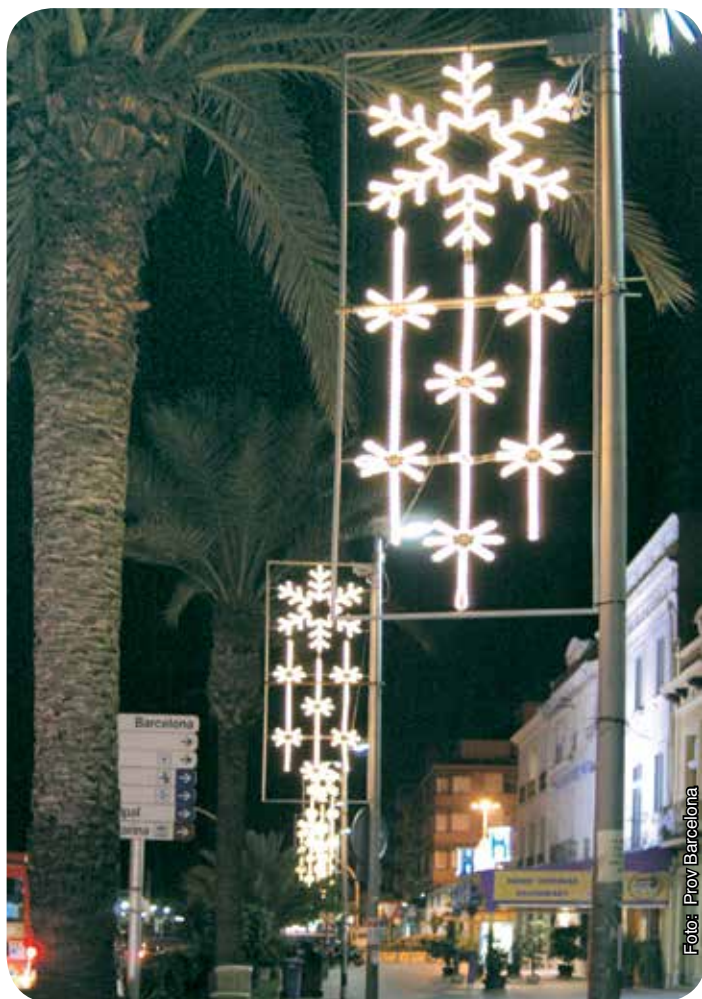
Figura instalada en farola con bridas metálicas en avenida amplia Figura a fanal amb brides metàl·liques a una avinguda ampla.
